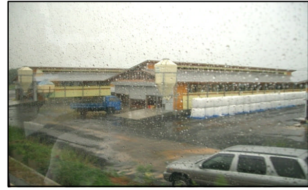
【建設された牛舎、隣に堆肥センターが建設中】
