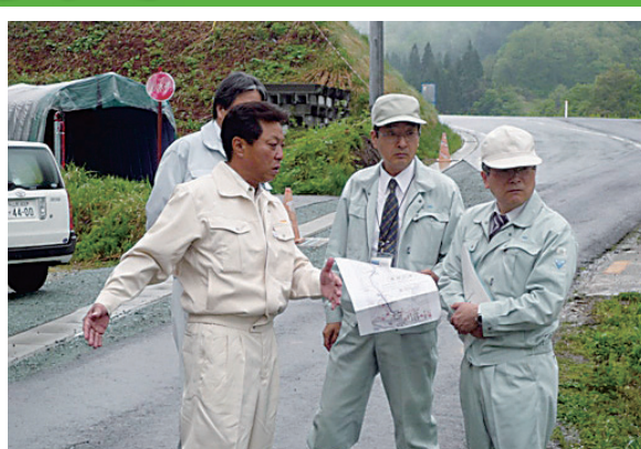
一般県道田代白岩線 待避所増設箇所について
